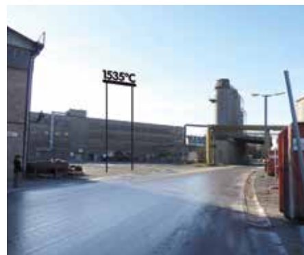
1535°, lieu dédié aux métiers créatifs, Differdange
